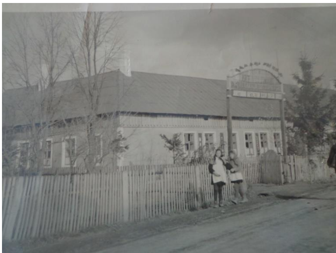
Будівля Іжівської восьмирічної школи №1 у 40-70-х роках ХХ століття
